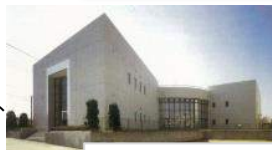
新校舎 (昭和60年3月竣工)
